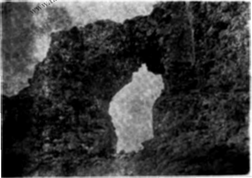
نمای مدخل تالار شرقی، وطاق آن با قالب کمر بندی
